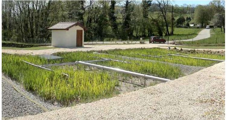
Les filtres à sable sont plantés de phragmites qui participent à l'infiltration et à l'épuration des eaux (supports bactériens, apport d'oxygène ...). Un dégrillage est nécessaire mais pas de système de décantation primaire.
